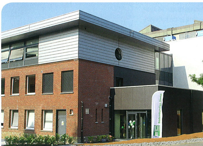
Op het oude gebouw werd twintig jaar geleden een extra verdieping gebouwd. Het nieuwe gebouw, opgetrokken in grijze leien, werd via glazen passerelles verankerd aan het bestaande.
